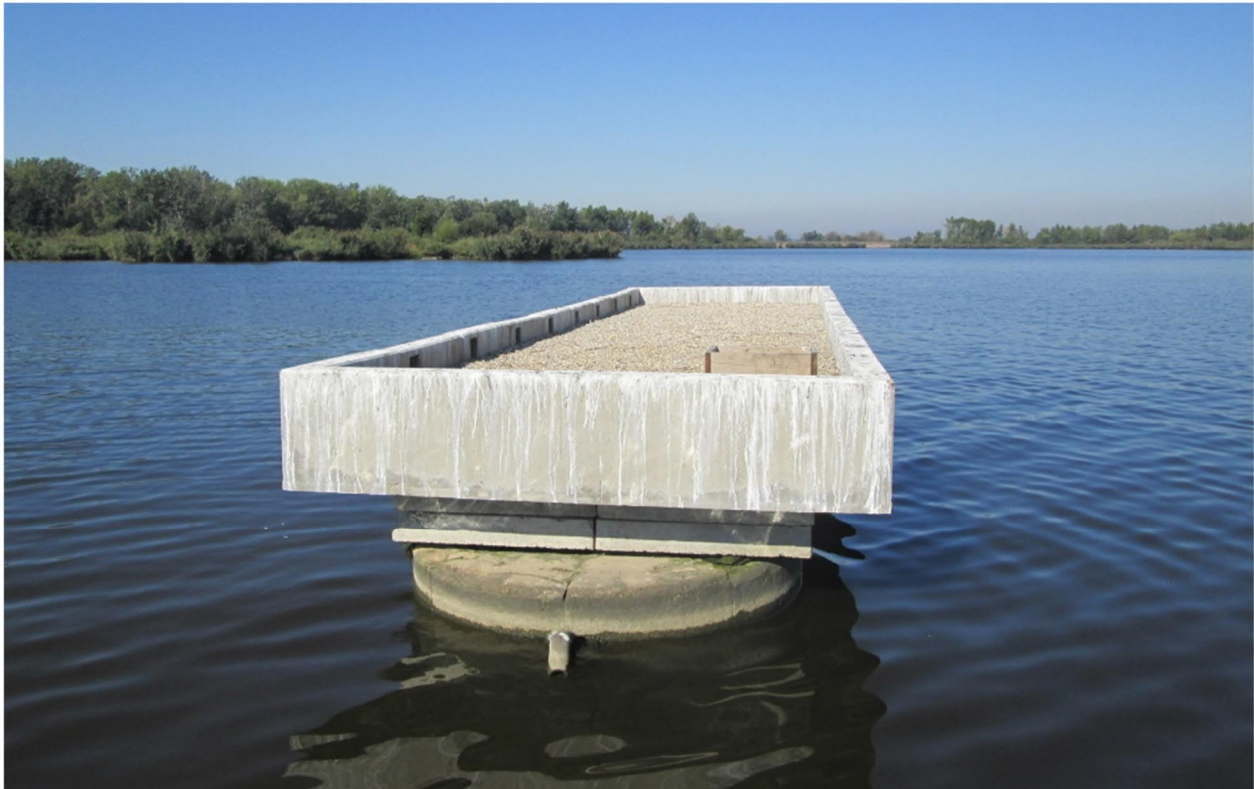
Obr.G. 1: Úprava pilířů původního mostu přes Dyji pro hnízdění rybáků ve střední nádrži zahrnuje zvýšení (ochrana proti povodním) a zvětšení plochy včetně úkrytů pro mláďata a ochranu proti vniknutí predátorů (09/2020)
