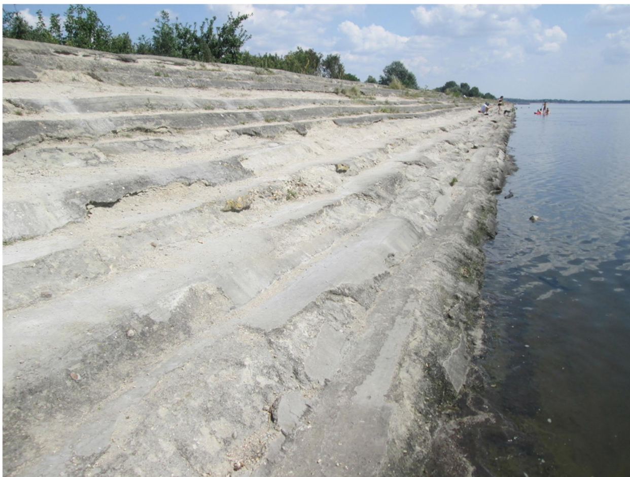
Obr. D.I.13: Celý severní břeh dolní nádrže a část jižního břehu tvoří betonové opevnění (2020)
