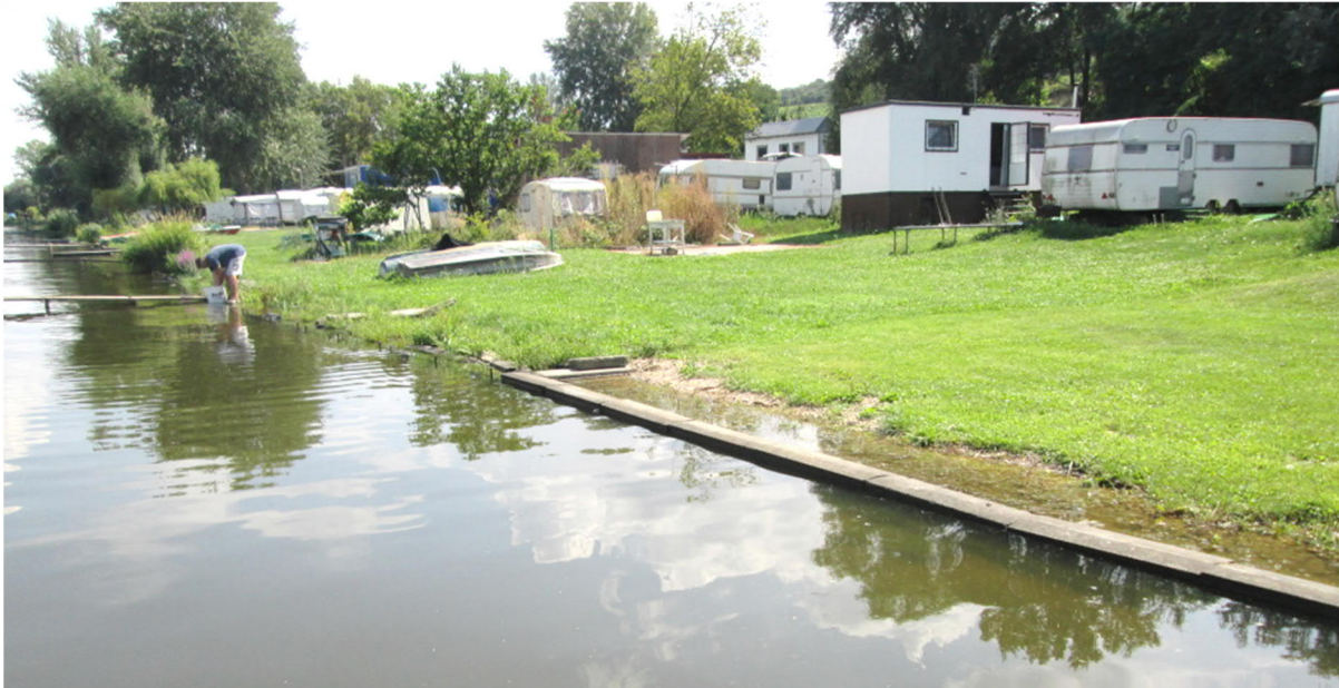
Obr. D.1.3: Charakter rekreačně využívaných pozemků, dolní nádrž, jižní břeh
