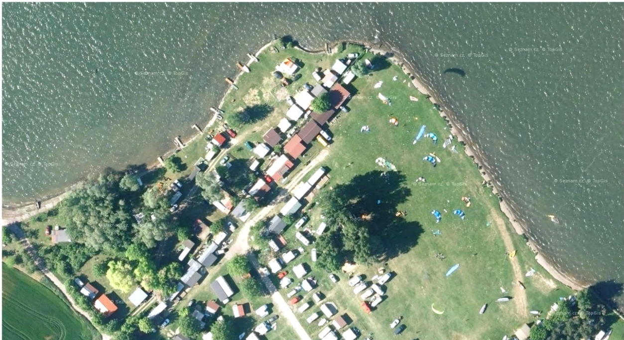
Obr. D.I.12: Část neopevněného břehu dolní nádrže (Kemp Pavlov) - vlevo plynulé ukončení betonového opevnění, vpravo maximální projev abraze (výrazné rozhraní mezi travním porostem a pláží) (Seznam.cz 2020, TopGis, 2018)
