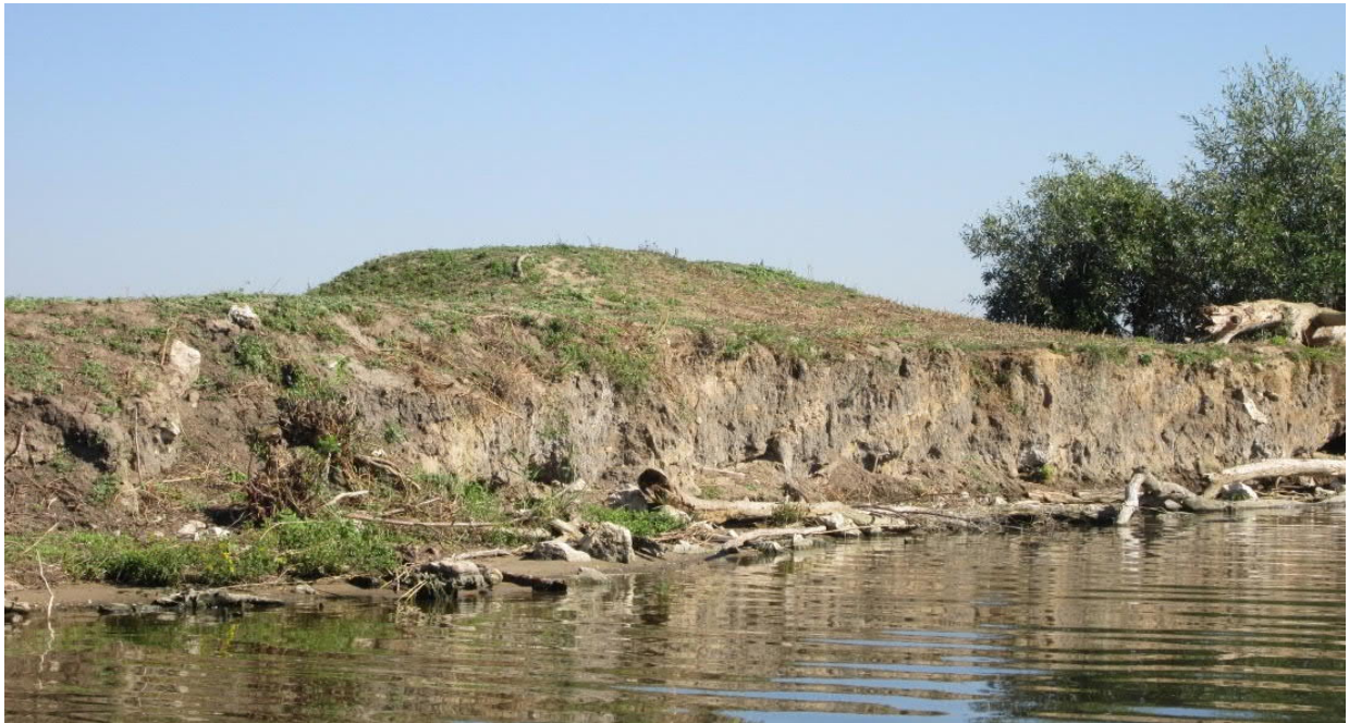
Obr. D.I.7: Maximální projevy abraze ve střední nádrži (9. 9. 2020, Deponie V). Na obr. abrazní srub na jižní straně Deponie V. Aktuální úroveň hladiny 170,13 m n. m. Je zřejmé, že v tomto případě navýšení terénu není nutné, ochrana proti abrazi a navýšení úzkých lemů využívaných ke hnízdění ano.
