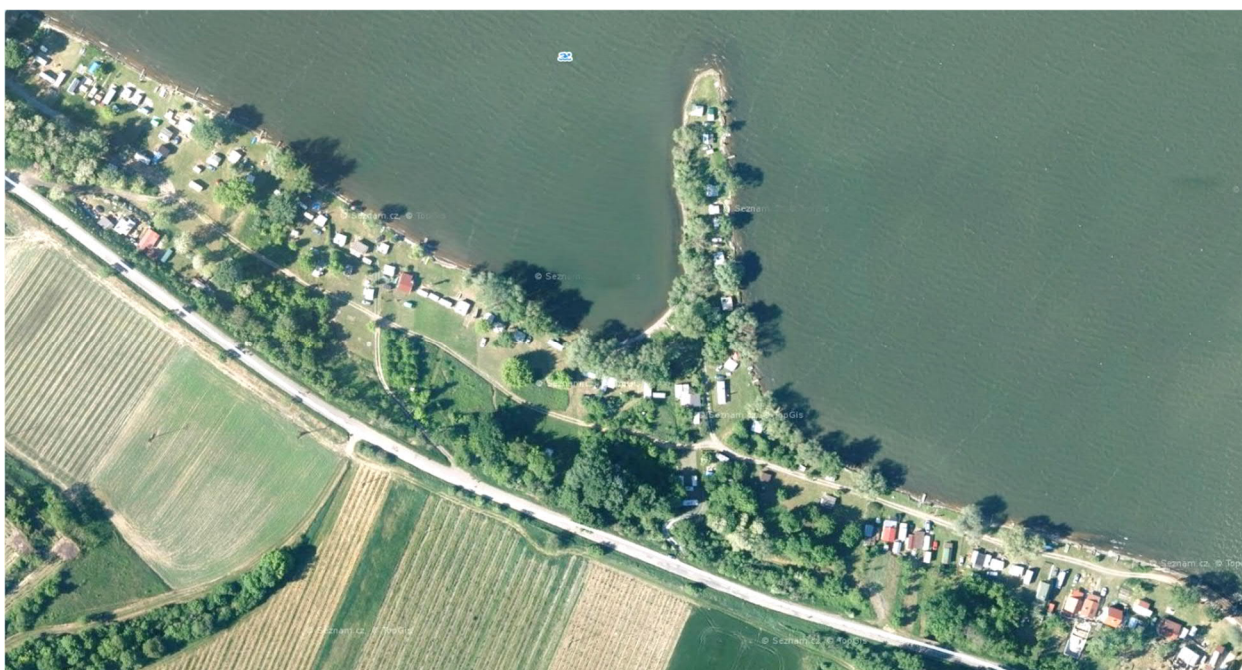
Obr. D.I.14: Úsek břehu dolní nádrže stabilizovaný pouze úpravou sklonu a štěrkovým záhozem. (seznam.cz, 2020)
