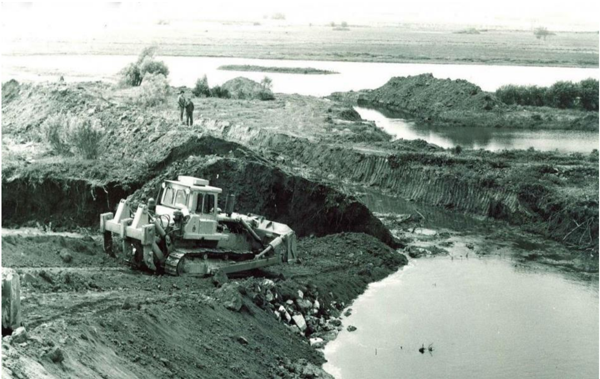
Obr. C.1.2: Výstavba vodního díla Nové Mlýny (1987)
