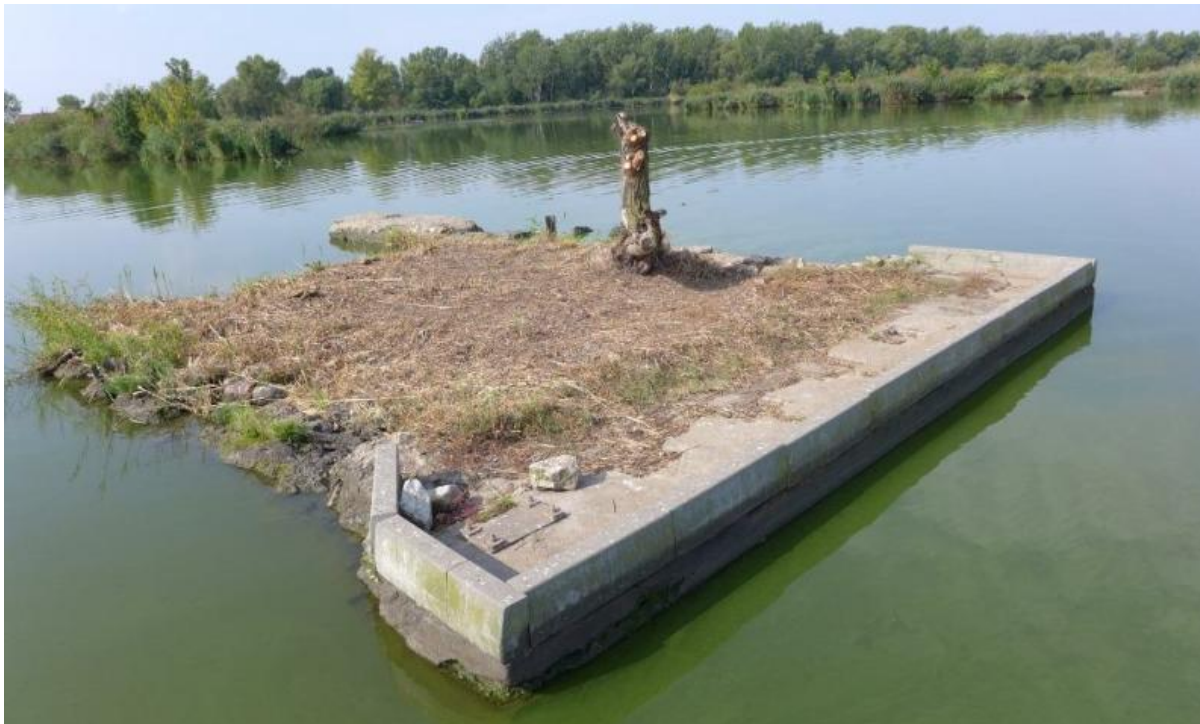
Obr.B.1.6-4: Nájezdová rampa, současný stav
