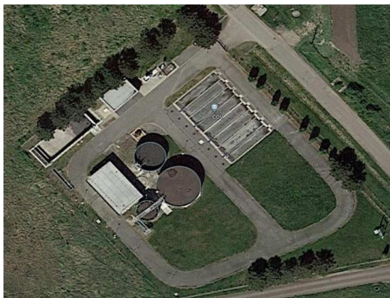
Obrázek 3: Pohled shora na areál ČOV, zdroj: www.google.com/maps
