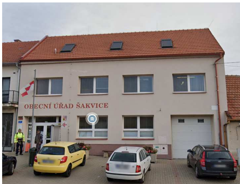
Obrázek 1: Pohled na budovu obecního úřadu v Šakvích, zdroj: www.google.com/maps
